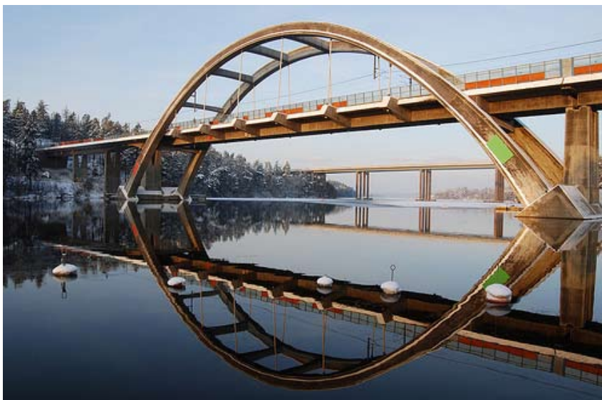
Bild över järnvägsbron och E18. De huvudleder som förbinder Stäksön med fastlandet.
